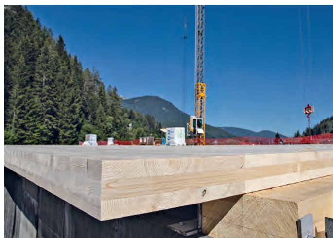
Der starke Trend zur Nachhaltigkeit forciert den Einsatz von BSP im Hausbau, auch mehrgeschossig (Fotos: Binderholz (o.), Pfeifer (u.))
